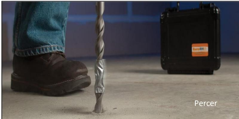
La profondeur et le diamètre du trou sont importants conformément aux normes ASTM F2170 (voir ASTM F2170 'Pratiques optimales' à la page 24). Pour une installation facile du capteur intelligent **Smart Sensor** et/ou du baril/base, un trou rond uniforme est essentiel. En utilisant un marteau rotatif et une mèche de maçonnerie ¾", percer un trou dans la dalle de béton selon la profondeur requise.
